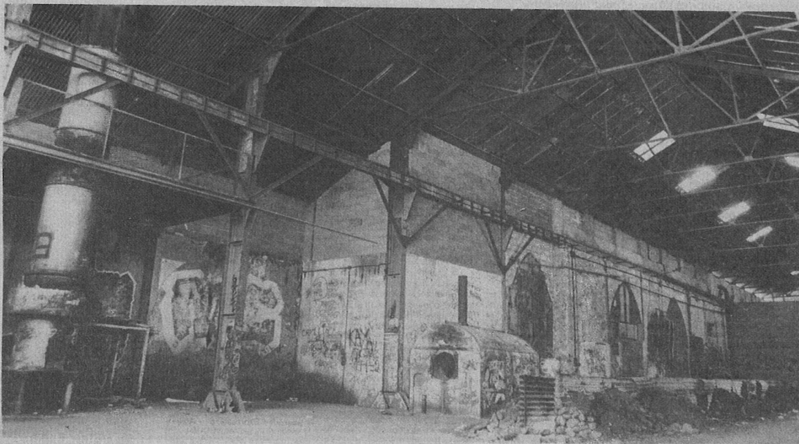
La grande halle n'a jamais fait l'objet d'aucune réhabilitation. Seule sa toiture sera entièrement refaite.
